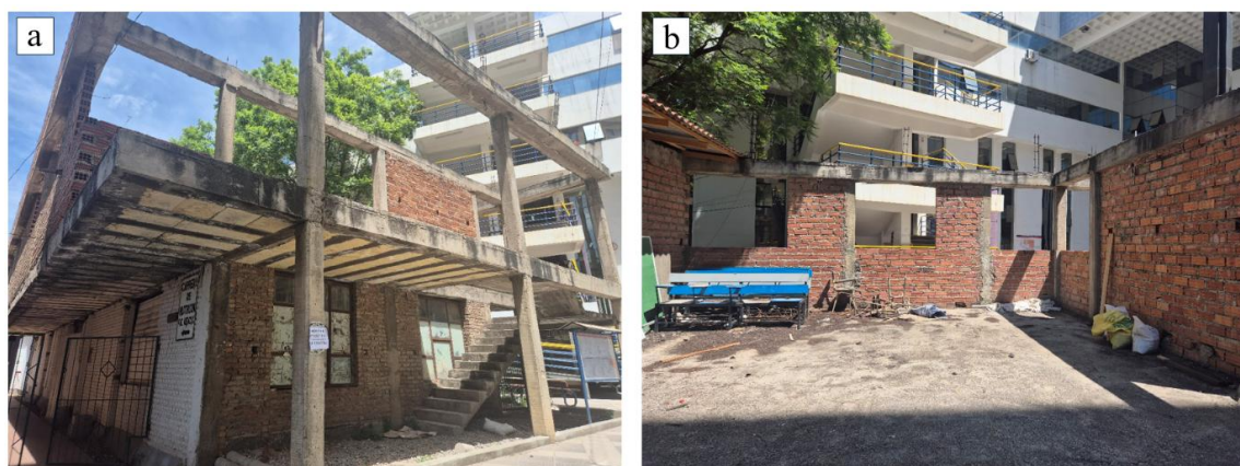
Figura 5. (a) Vista general y (b) planta alta de la edificación.
