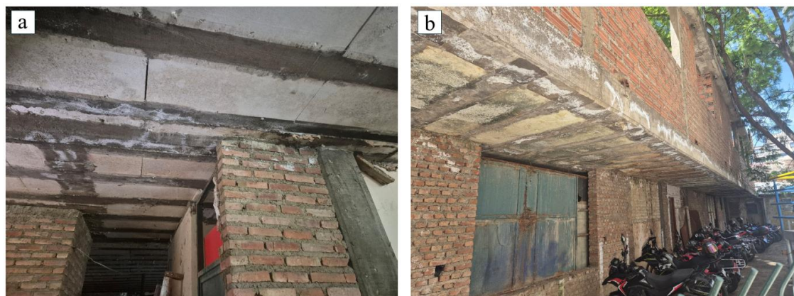
Figura 6. Superficie inferior de: (a) la losa y (b) voladizo.
