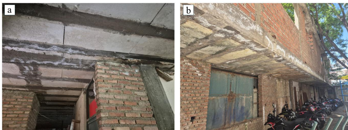
Figura 6. Superfície inferior de: (a) laje e (b) balanço.
