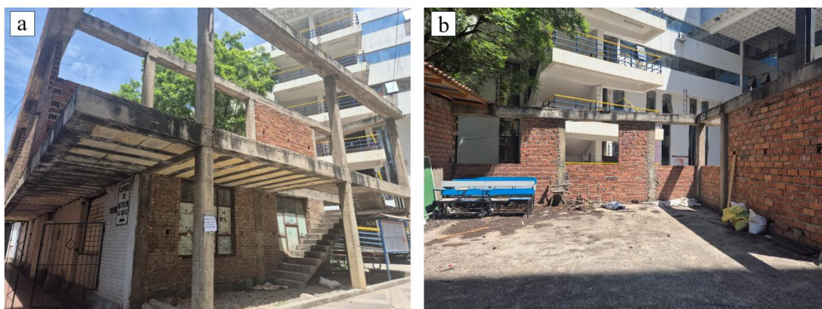
Figura 5. (a) Vista geral e (b) pavimento superior da edificação.
