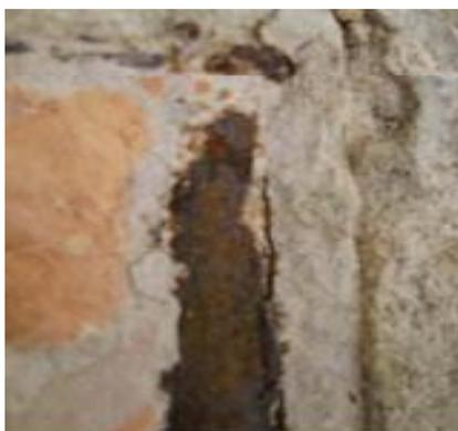
Figura 5. Armadura longitudinal corroída nos pilares.
