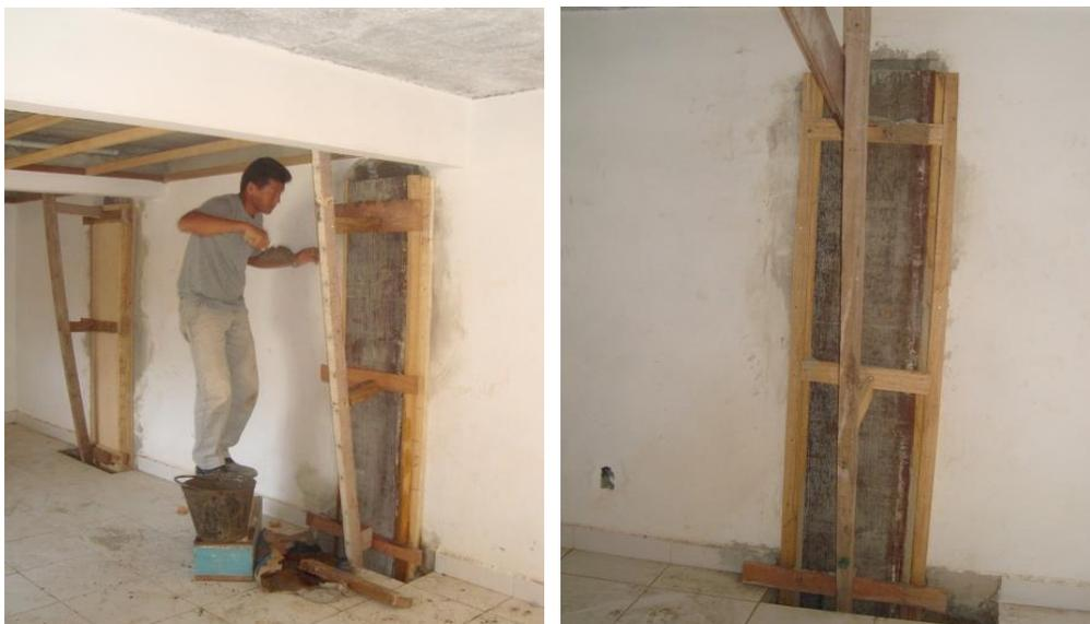
Figura 9. Concretagem do reforço dos pilares.
