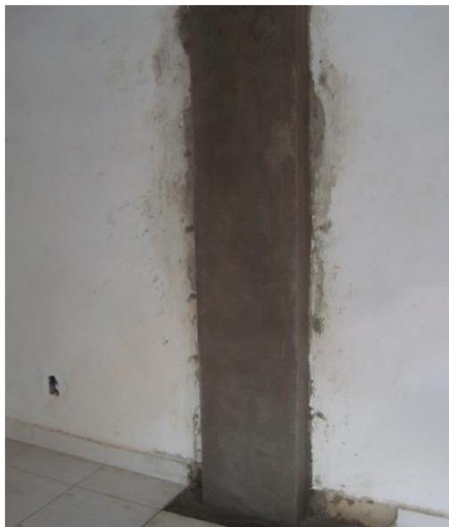
Figura 10. Aspecto final dos pilares reforçados.
