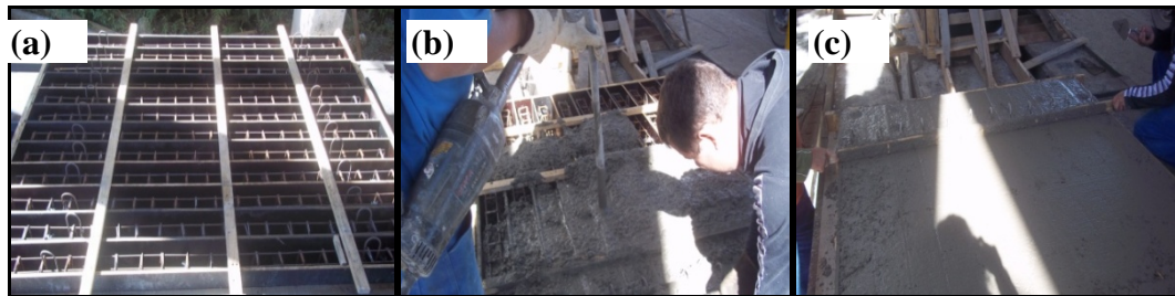
Figura 2. Fabricación de las vigas de concreto armado - (a) Moldes con armado listo para el vaciado; (b) Vaciado y vibrado ; (c) Nivelación del concreto en los moldes.
