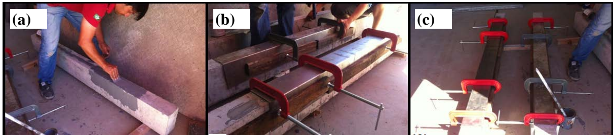
Figura 4. (a) Aplicación del adhesivo epóxico para anclar los perfiles de acero; (b) Colocación de fijadores; (c) Sistema de fijación final de las chapas.
