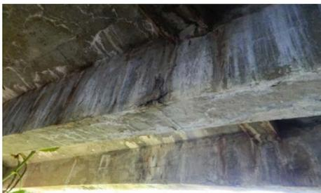
Figura 4. Presença de eflorescências, deslocamento do revestimento de concreto e manchas marrom-avermelhadas decorrentes do processo de corrosão das armaduras.
