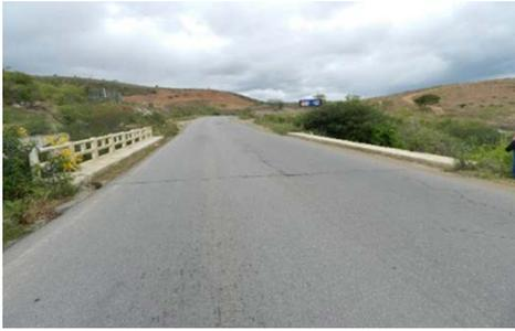
Figura 9. Ausência de guarda-corpo na lateral da ponte
