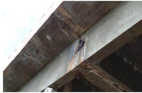
Figura 7. Aparelho de apoio metálico em um dente Gerber com visíveis danos e infiltrações.
