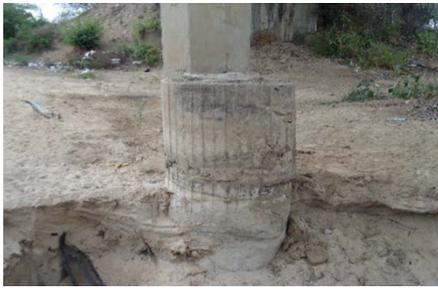
Figura 6. Erosão na fundação e grande excentricidade do pilar em relação ao tubulão.
