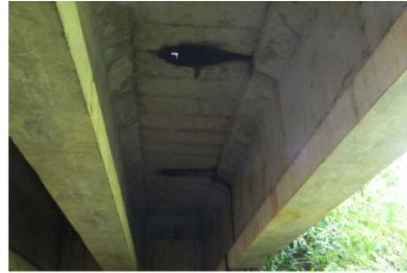
Figura 10. Dreno danificado provocando infiltração e manchas de umidade na laje entre longarinas
