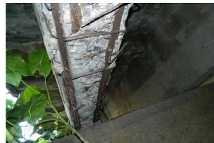
Figura 5. Armaduras expostas e oxidadas nas longarinas, exibindo inclusive estribos rompidos.
