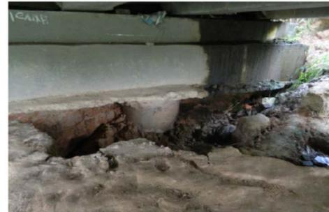
Figura 12. Presença de grande erosão na fundação.
