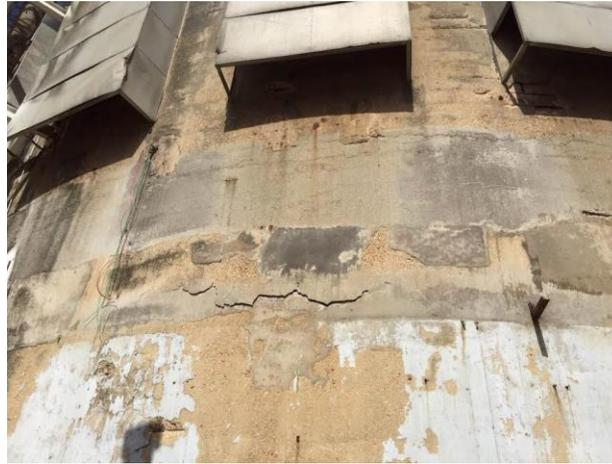
Figura 4. Detalle de reparaciones localizadas donde se observa la separación de concreto reciente y anterior, lo que ocasiona delaminación del concreto y zonas anódicas que favorecen a la formación de celdas de corrosión.
