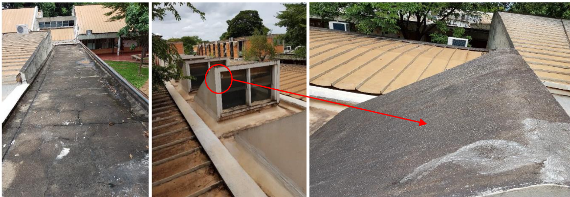
Figura 9, Figura 10 e Figura 11. Estrutura de suporte sem telhado / Claraboias.
