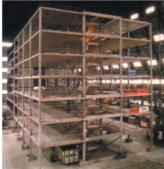
Figura 16. Perspectiva de la estructura prototipo de concreto armado diseñada para el experimento de simulación de fuego en Cardington (Chana & Price, 2003).
