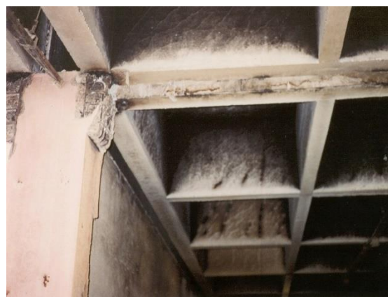
Figura 12. Deslocamento de apoio de estrutura pré-moldada submetida a incêndio
