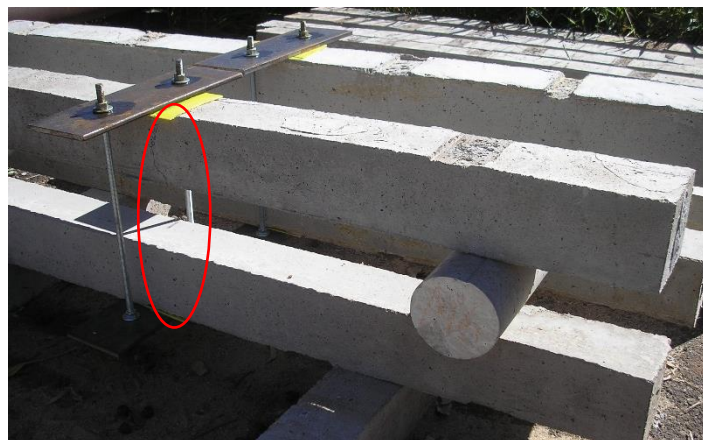
Figura 8. Mapeamento das fissuras nos concretos que ficaram sob carregamento central permanente por 24 meses (M24umCCP).
