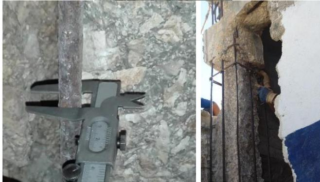
Medición del diámetro del acero de refuerzo, si la pérdida de diámetro era mayor a la permisible, el acero era completado o sustituido. En algunos casos se colocó acero de refuerzo transversal completo por el desgaste excesivo
