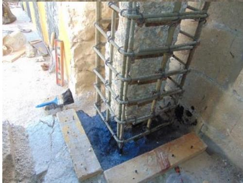
Antes de realizar el desplante, la base de todos los elementos fue recubierta con un impermeabilizante asfáltico alrededor del suelo para evitar alguna penetración de humedad o agentes corrosivos
