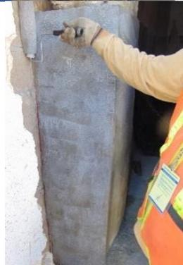
Posterior al colado y después del descimbrado, se aplicó una membrana de curado al concreto para asegurar la durabilidad
