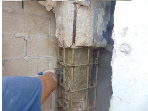
Previo al colado, se aplicó un puente de adherencia para asegurar la homogenización del concreto nuevo con el viejo, éste también tiene la función de sellador
