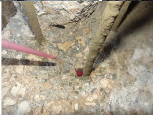
Se perforaron agujeros para la colocación del nuevo acero que sustituyera al corroído. Para su correcto anclaje, se inyectó una resina epóxica de alto rendimiento para altas cargas
