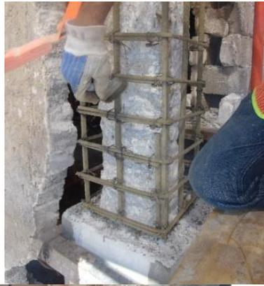
Por la experiencia previa de la inspección, se recomendó aplicar al acero un convertidor de óxido
