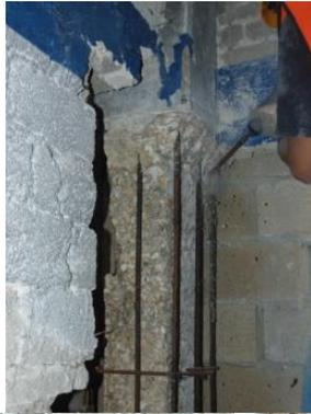
Escarificación mecánica para eliminar el concreto en mal estado y descubrir el acero de refuerzo
