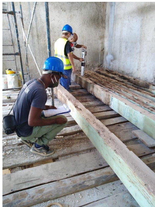
Figura 4. Inspeção e classificação visual de vigas desmontadas
