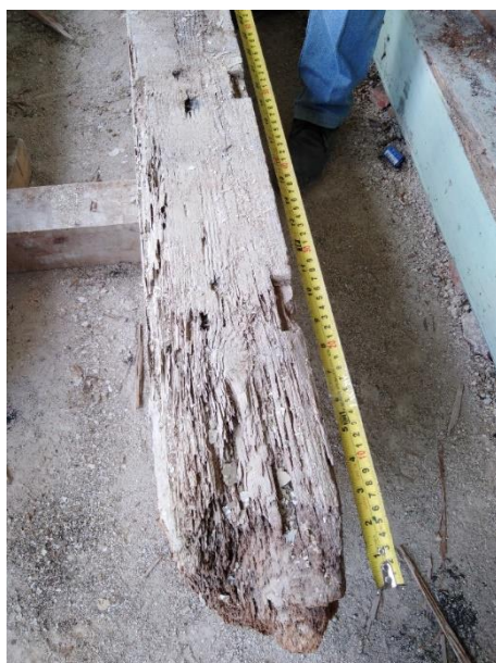
Figura 7. Fita métrica da seção do feixe afetada
