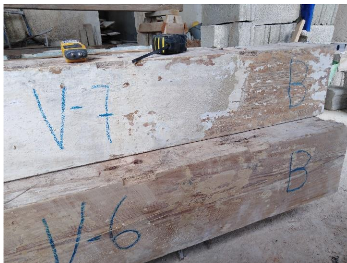
Figura 8. Identificação de vigas de madeira
