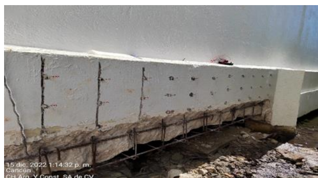
Figura 16. Instalación de ánodos dentro del concreto huésped con verificación de la instalación en Cancún, México.
