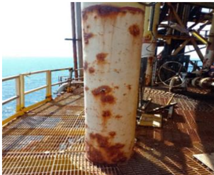
Figura 1. Corrosão alveolar.
