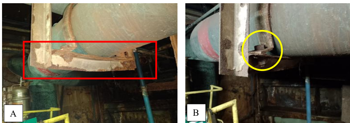
Figura 6. Flexão em parafuso e deformação da cantoneira que apoia o spool .
