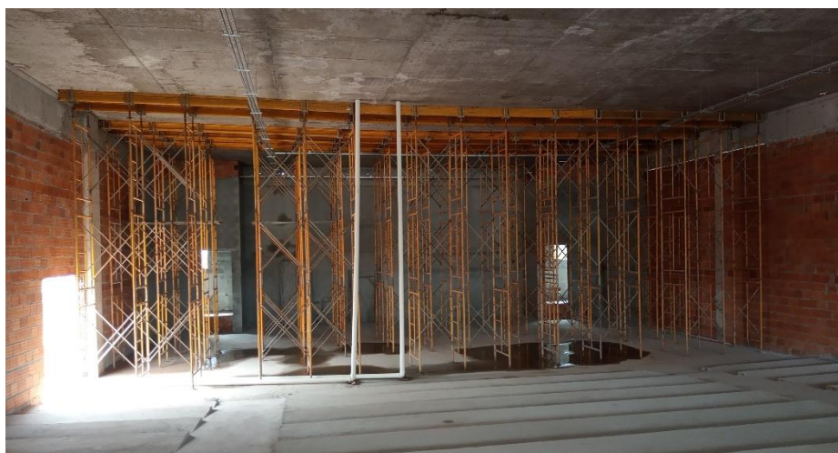
Figura 5. Vista inferior de la losa de cubierta del auditorio.
