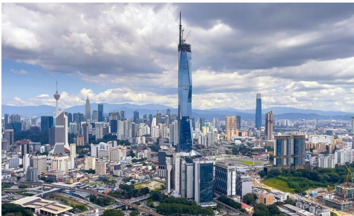
Figura 1 Foto da construção do Merdeka 118 em Kuala Lumpur
