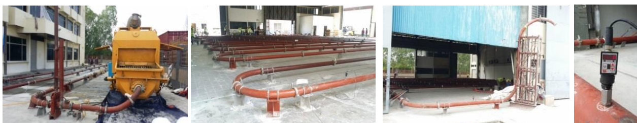
Figura 7. Layout de tubulação horizontal de concreto C105 para teste de bombeamento.
