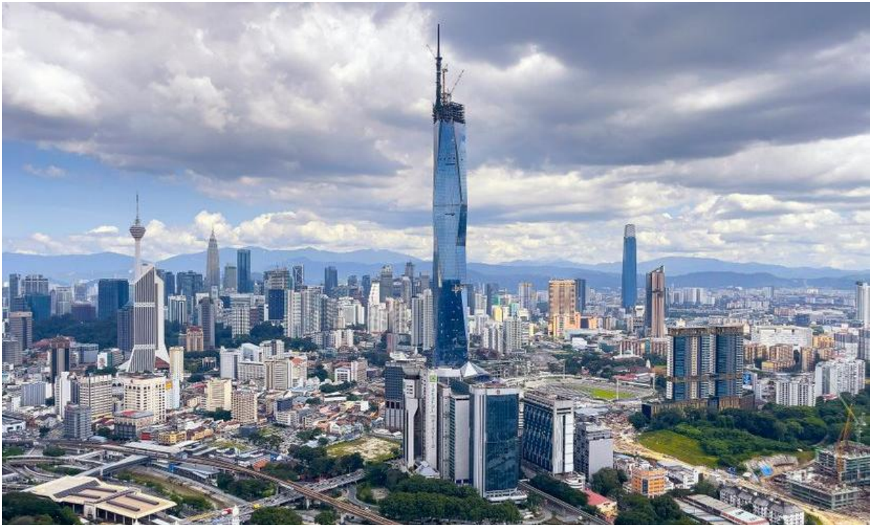
Figura 1 Foto de la construcción de Merdeka 118 en Kuala Lumpur
