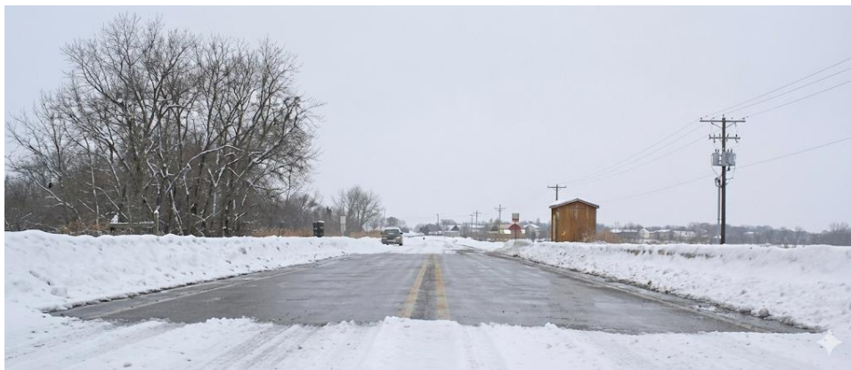
Figura 10. Aplicación real de deshielo en pavimentos conductores. (Adaptado de Tuan and Yehia, 2004).
