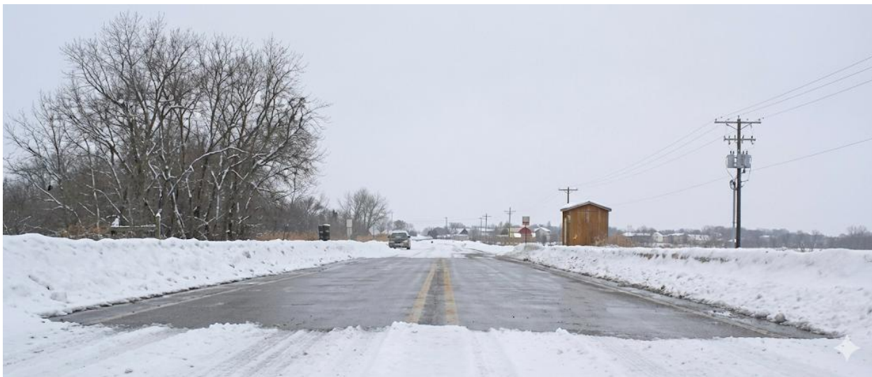
Figura 10. Aplicação real de descongelamento em pavimentos condutivos (Adaptado de Tuan and Yehia, 2004).
