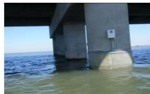
Figura 5. Protecção com fibra de vidro de pilares
