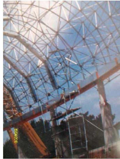
Figura 5. La estructura se montaba sobre el terreno y se levantó a su posición definitiva con grúa.
